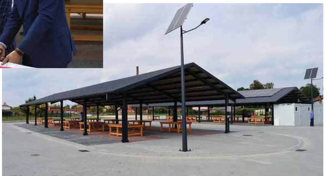
Zmodernizowany obiekt posłuży lokalnym handlarzom i społeczności.
