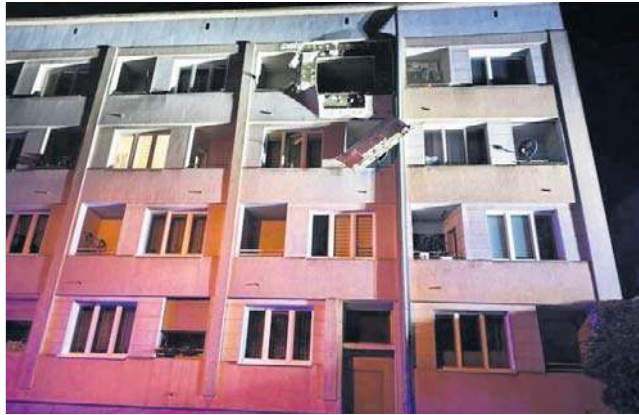
Do eksplozji na czwartym piętrze bloku przy ul. Worcella doszło w sobotę wczesnym rankiem
