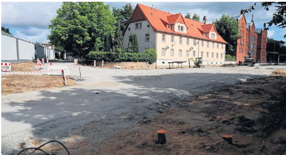
Wykonawca – spółka Domar z podkoszalińskiego Tatowa – zerwał stary asfalt i zaczął już układać pierwsze warstwy podbudowy pod zupełnie nową nawierzchnię
