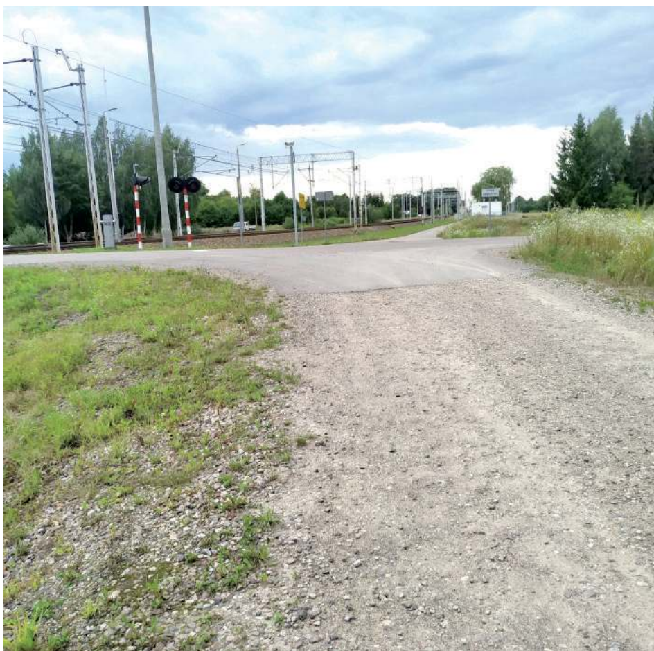
Już w grudniu droga w Sadurkach będzie miała nową nawierzchnię i połączenie z drogą powiatową
