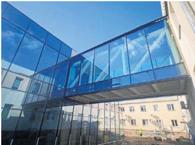
Prace przy rozbudowie tarnobrzejskiej uczelni mają potrwać do końca 2024 roku
