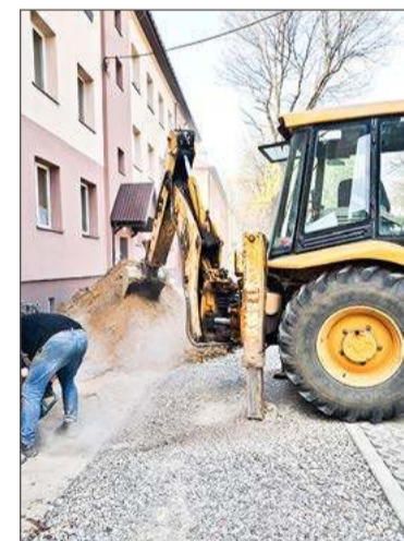
Prace wzdłuż Krakowskiej prace dobiegają końca.
