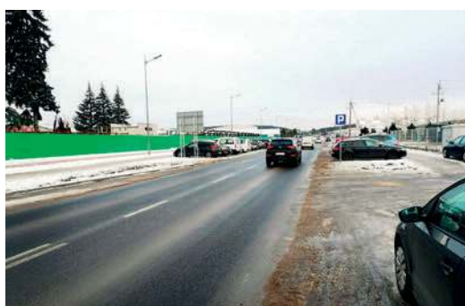
Ul. Nowa po rozbudowie
