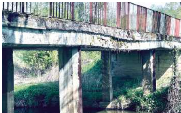
Widać, że most jest w opłakanym stanie i wymaga gruntownego remontu
