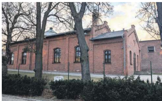
Co ma być zrobione? Przede wszystkim wymiana podłogi sportowej na nowoczesną nawierzchnię „powierzchniowo-elastyczną”
