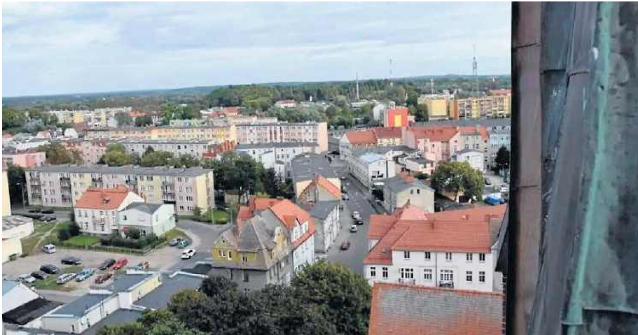
Środki te mają pomóc pokryć nakłady konieczne na zabezpieczenie zabytku przed dalszą degradacją
