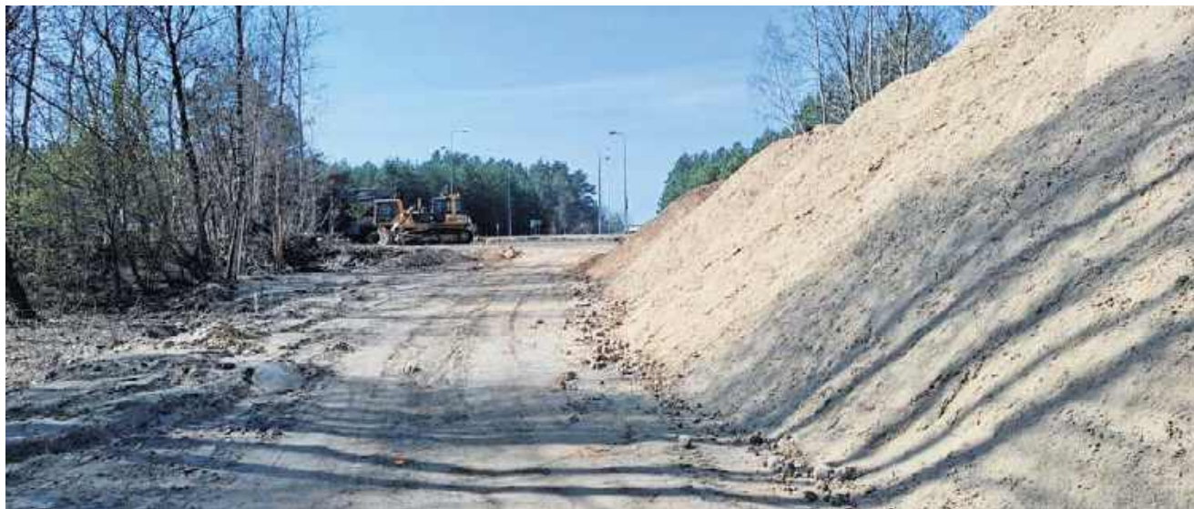
Budowa łącznika między małą obwodnicą Szczecinka i budowaną trasą ekspresową S11
