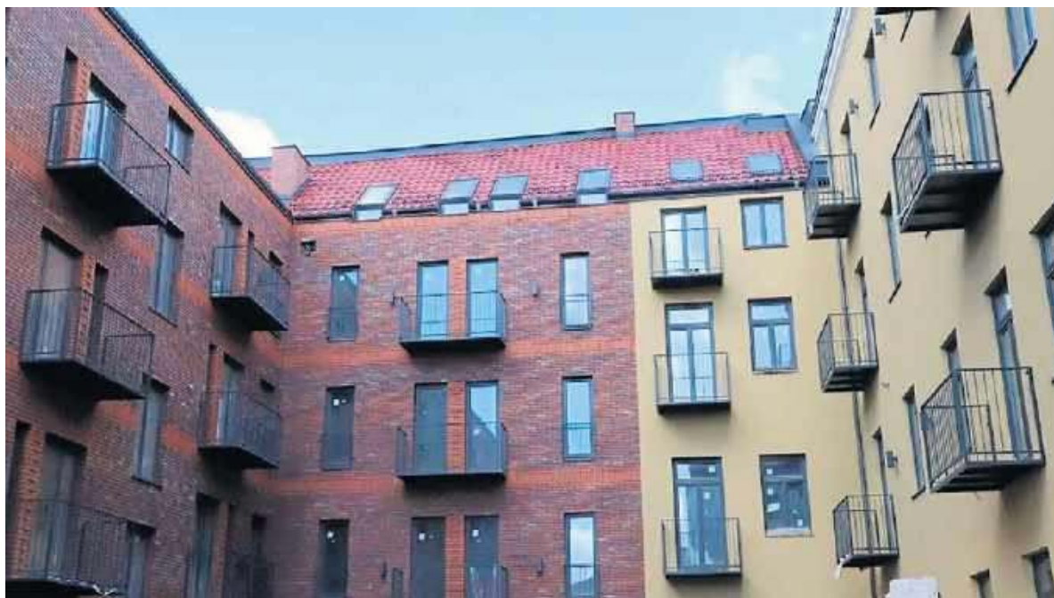
Kamienice przy ulicach Bóżnicznej i Wałowej mają wspólny dziedzińec. Trwają prace wykończeniowe.
