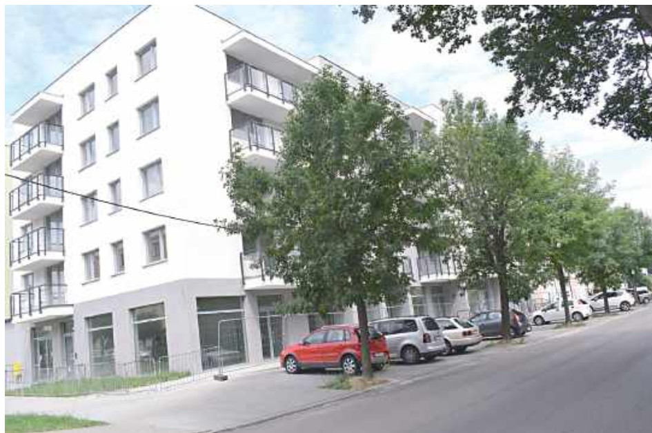
Blok odróżnia się od innych spółdzielczych nowoczesną elewacją, przeszklonymi balkonami. Na dole są miejsca dla punktów handlowych czy usługowych. Na trzech piętrach - mieszkania. Drzewa stanowią przeszkodę dla pojazdów straży pożarnej
