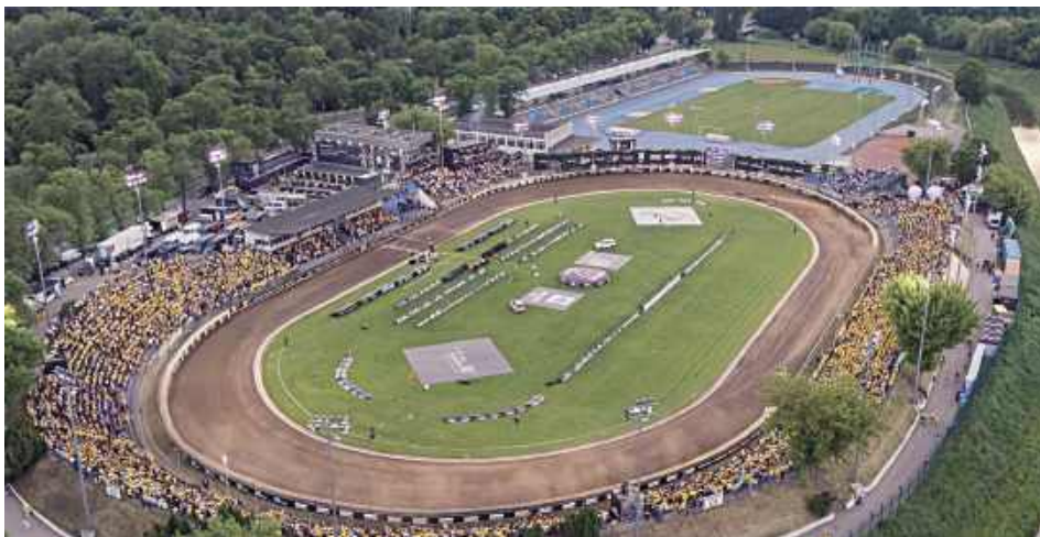
Przebudowa i rozbudowa stadionu przy Al. Zygmunta obejmie budowę nowoczesnego, wielofunkcyjnego obiektu dla 16,6 tys. widzów
