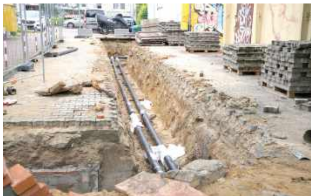
Dzięki pozyskanej dotacji oraz niskooprocentowanej pożyczce z Narodowego Funduszu Ochrony Środowiska i Gospodarki Wodnej, puławski OPEC zmodernizuje te najbardziej wysłużone odcinki miejskiej sieci ciepłowniczej
