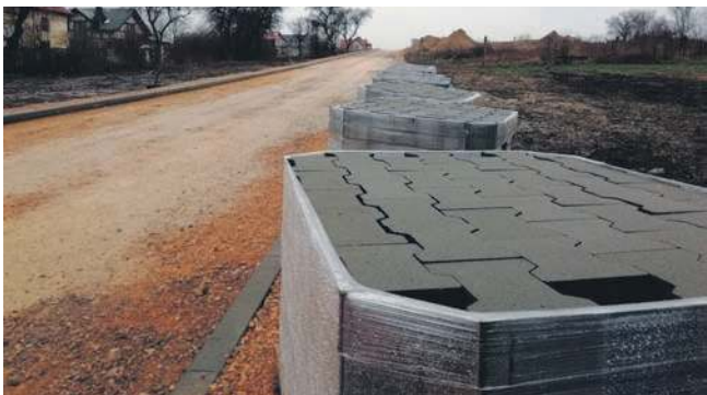
Kostka przygotowana do brukowania Leszczynowej w Chrzanowie
