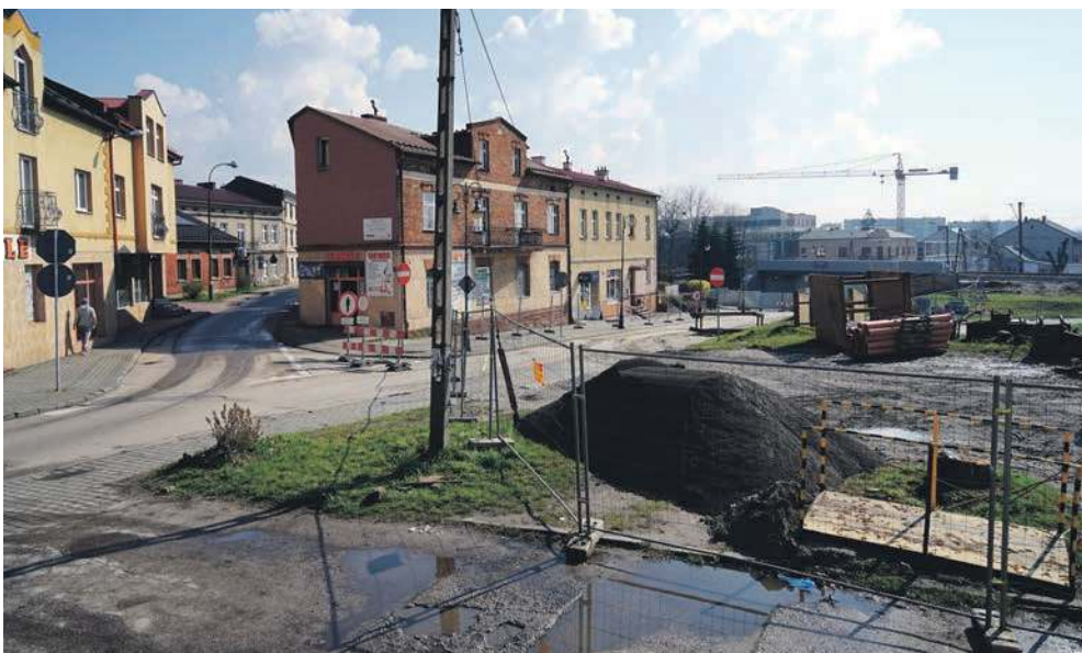
Budowa ronda na Krakowskiej będzie wymagała okresowego zamknięcia wjazdu z Zielonej
