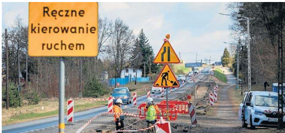
W Żołędowie trwa modernizacja drogi wojewódzkiej nr 244
