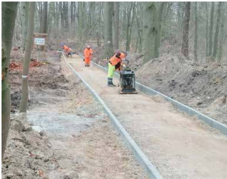
W trakcie prac na odcinku leśnym ścieżki nie planowano ławek, ale na pewno można je będzie postawić w przyszłości
