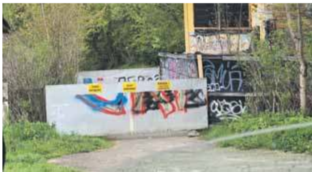
Zamknięte przejście na Bulwarach Słowackiego.
