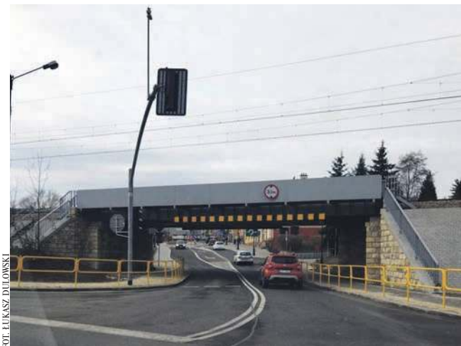
Wiadukt na ul. Krakowskiej w Chrzanowie
