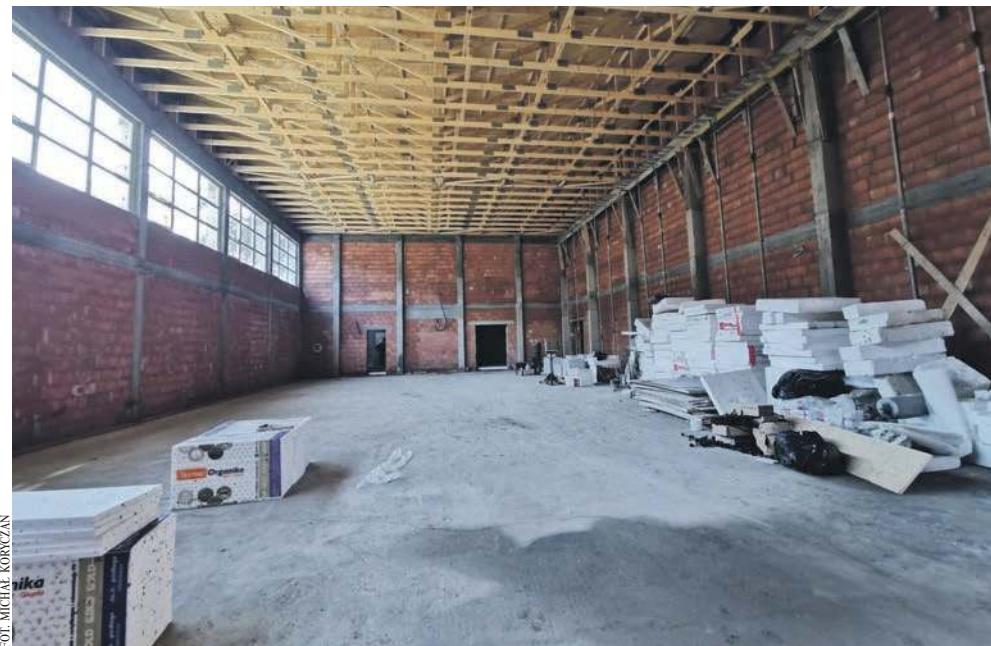
W Jankowicach powstaje nowa sala gimnastyczna
