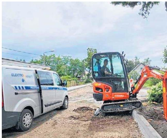
Adam Łotysz, Elektrokraft - Usługi elektryczne, Gorzów Wielkopolski
