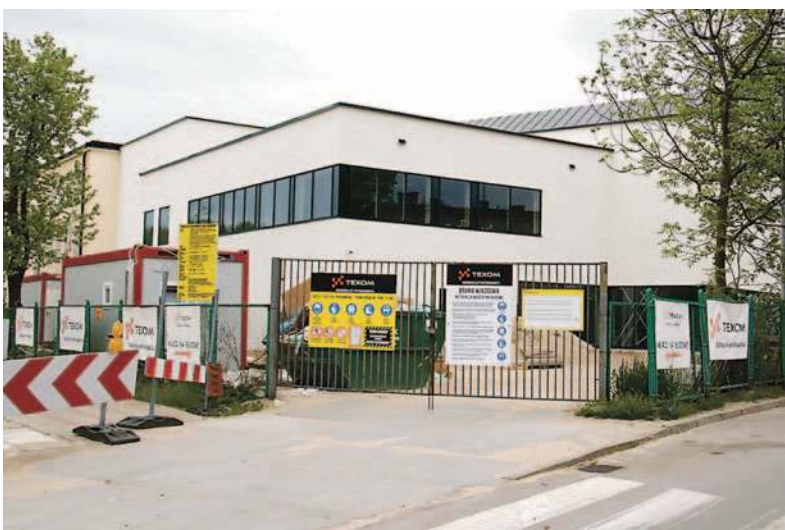
Dla przypomnienia: budowa hali sportowej z zapleczem przy PSP nr 3 pochłonie blisko 8,5 mln złotych
