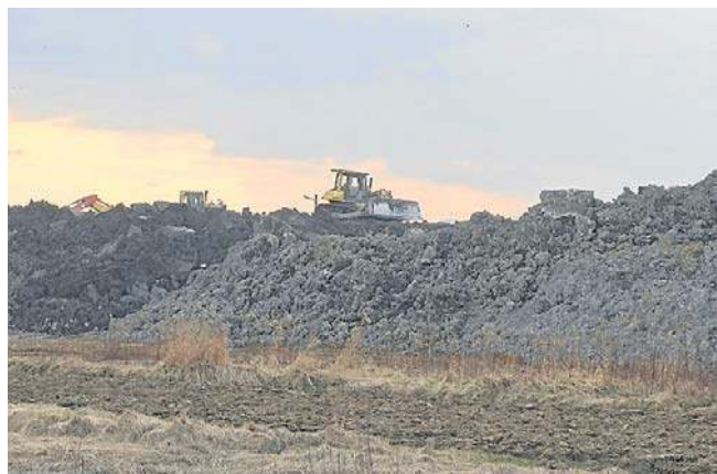
Ziemi z dnia na dzień przybywa, a w miejscu, gdzie jest usypywana od rana do wieczora pracuje ciężki sprzęt
