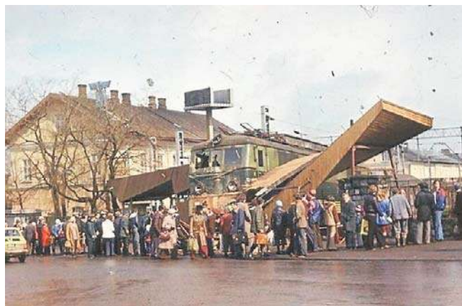
Skład pociągu towarowego przebija kozły, bramę stacji PKP i wjeżdża na chodnik przy ul. Kościuszki
