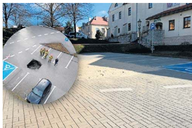
Tak wygląda obecnie parking w Olkuszu, na którym powstało około 3-metrowe zapadlisko
