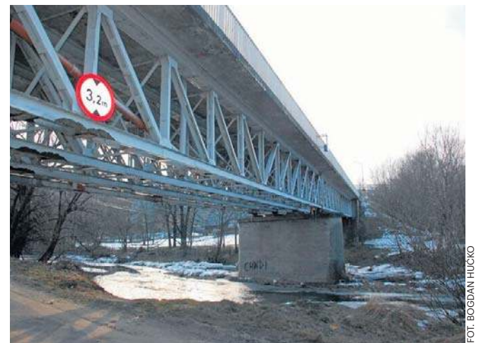
Stary most na Wisłocy zostanie rozebrany. Zakończenie budowy nowego planowane jest na koniec 2026 roku
