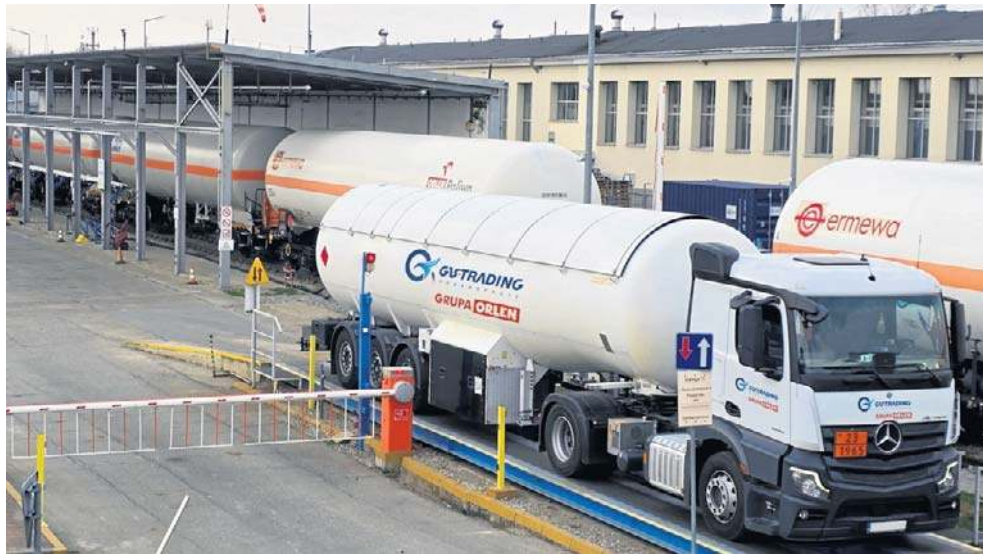
Gas Trading Podkarpacie Sp. z o.o. dysponuje w Dębicy własną bazą magazynową, terminalem przeładunkowym oraz boczną koleją, co znacząco zwiększa jej niezależność operacyjną
