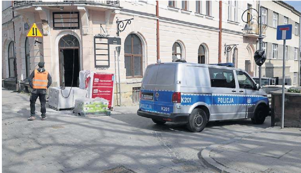
Kamienica przy ul. Blich 1 przechodzi gruntowny remont, który ma przekształcić ją w nową siedzibę Muzeum Rzemiosła
