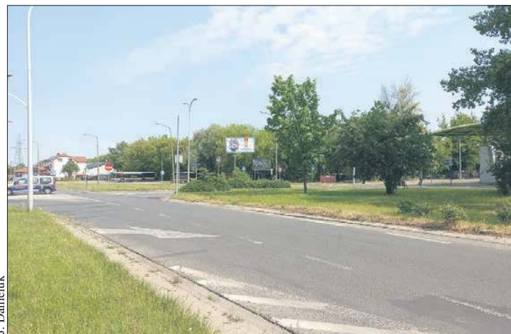
Na ulicy Chopina – na wysokości dworca kolejowego – powstanie rondo, które poprawi bezpieczeństwo ruchu drogowego w tym miejscu
