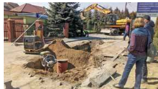
Budowa sieci kanalizacyjnej ul. Wiśniowa i Winogronowa
