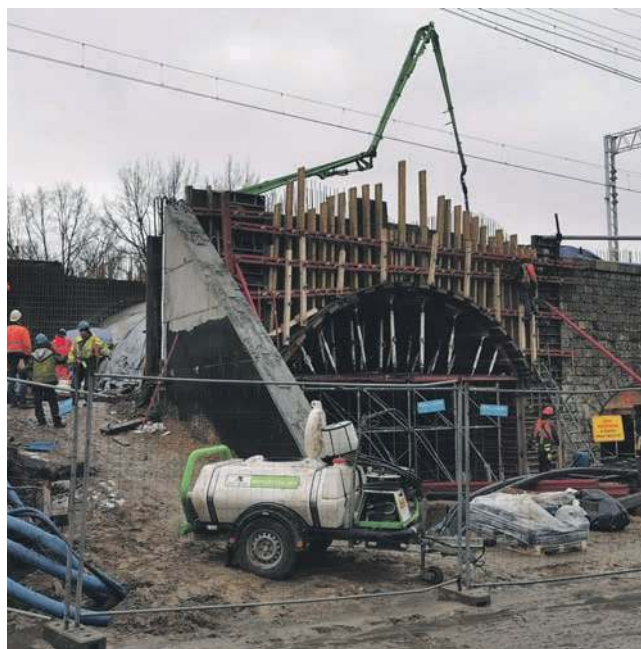
Wiadukt nad ul. Sienną
