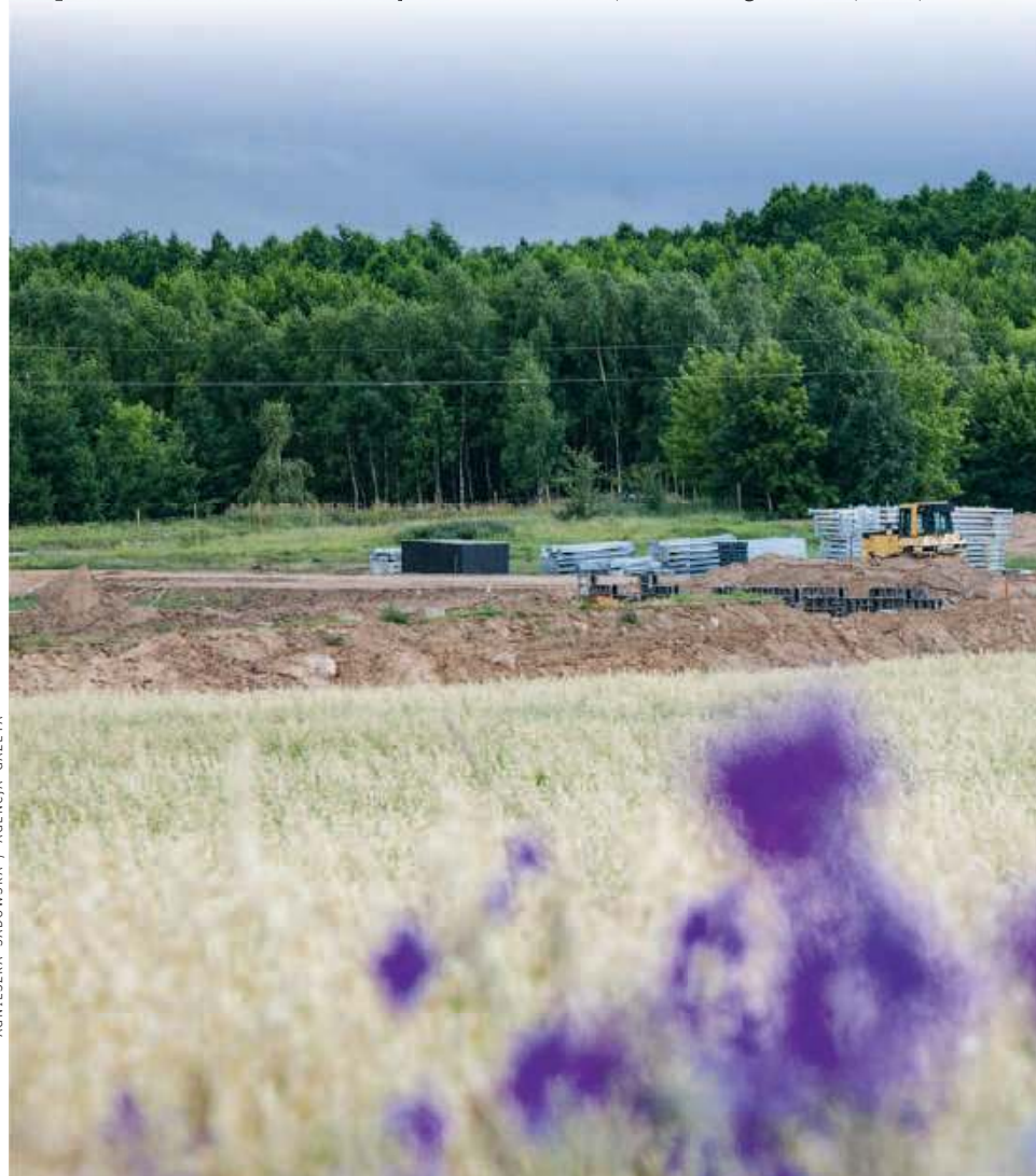
Okolice wsi Górka, gdzie trwają przygotowania do budowy kurników; sto metrów dalej znajduje się rezerwat.
