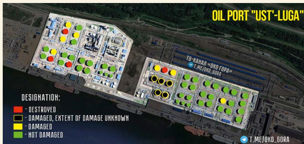
Wyniki powtarzających się w marcu ukraińskich ataków dronowych na rosyjski port Ust-Ługa, gdzie mocno ucierpiały zbiorniki do przechowywania przeznaczonej na eksport ropy i produktów naftowych. Zniszczone zostały cztery zbiorniki, siedem uległo uszkodzeniu, a nieuszkodzonych pozostało 40, tj. 71 proc.
