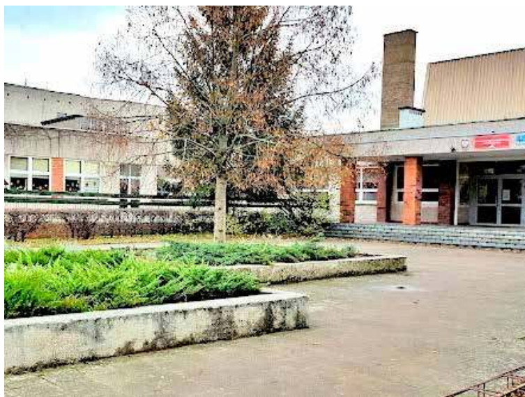
Na pewno wiadomo, że obecnie nie wystarczy środków na przebudowę gmachu II LO i SP nr 3
