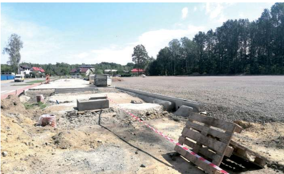
Do tej pory rozebrany został istniejący budynek magazynowy i wykonana kanalizacja deszczowa, odwodnienie oraz drenaż płyty boiska. Gotowe są fundamenty pod trybuny, linie kablowe i większość chodników. Zamontowane są też słupy oraz maszty oświetleniowe. Na dokończenie czeka ostatnia warstwa konstrukcyjna podbudowy boiska
