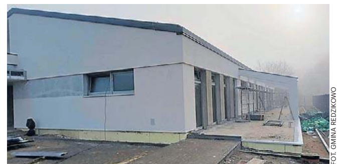
Budowa żłobka w Głobinie zmierza do końca
