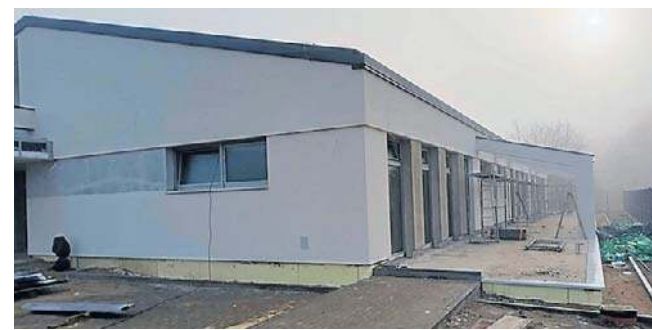
Budowa żłobka w Głobinie zmierza do końca
