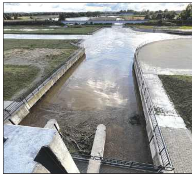
■ Zbiorniki retencyjne pełnią ogromną rolę w systemie przeciwpowodziowym
