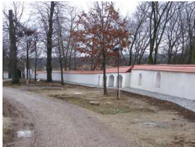
Mur przy klasztorze w Radecznicy był remontowany od maja
