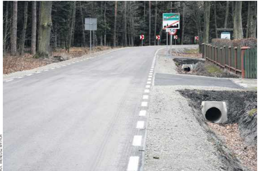
Przebudowana droga w Maziarni w gminie Bojanów
