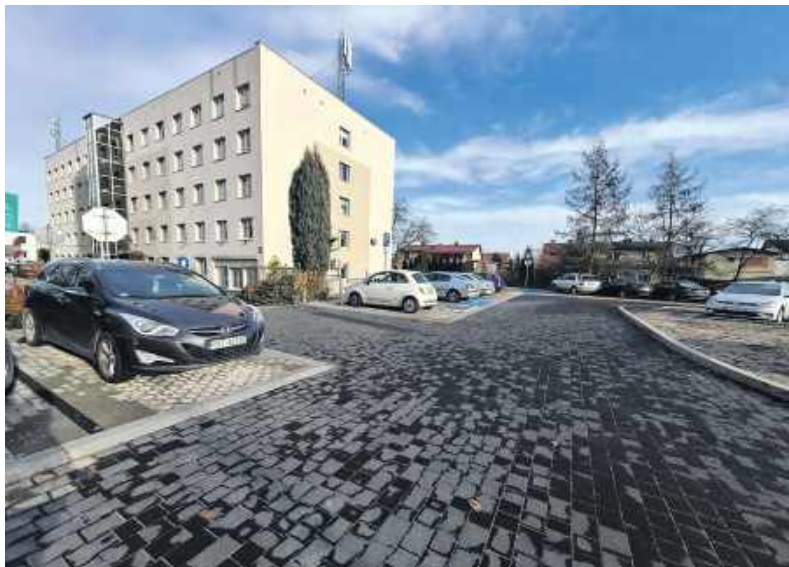
Z wyremontowanego parkingu korzystają okoliczni mieszkańcy oraz petenci Starostwa Powiatowego
