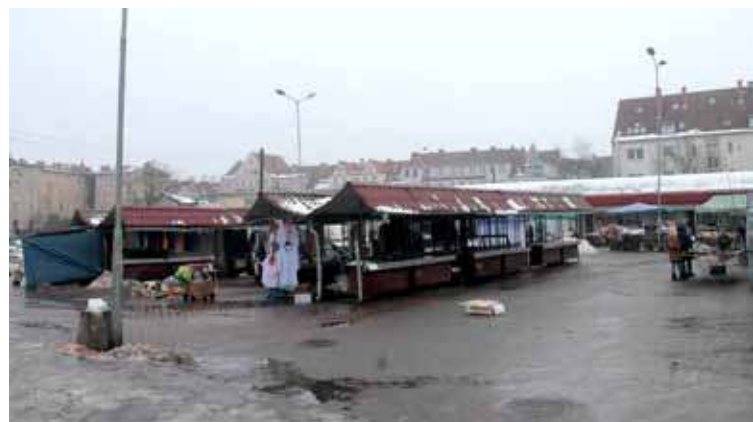
Remontowi ma ulec plac targowy na ul. Reja
