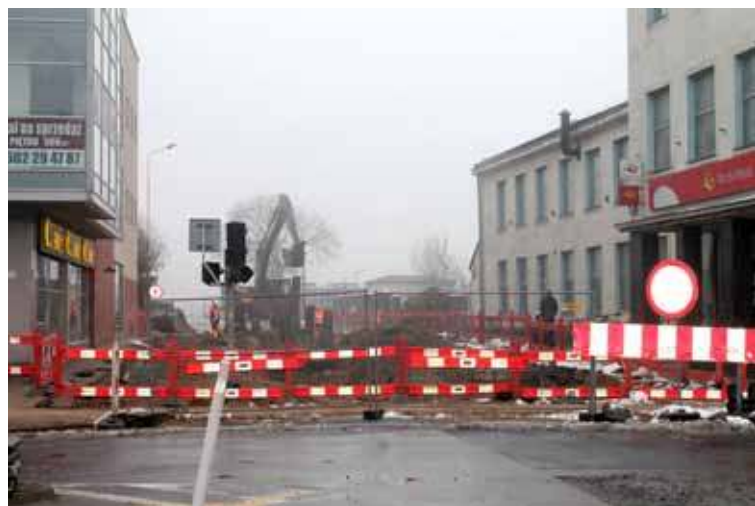
W następnym roku będzie kontynuacja budowy Park and Ride
