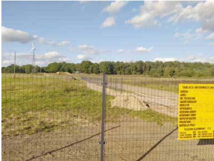
Na miejscu m.in. ogrodzenie i tablica informacyjna
