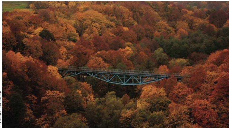
Most kolejowy w Dolinie rzeki Walszy ma 28 metrów wysokości
