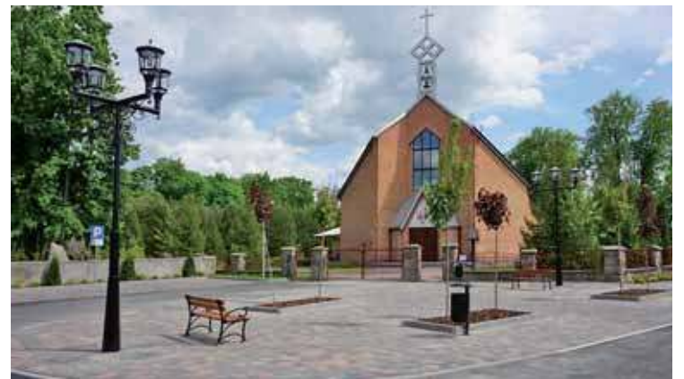
Przy kościele utwardzono nawierzchnię dróg manewrowych, ułożono chodniki z kostki brukowej oraz utwardzono miejsca parkingowe
