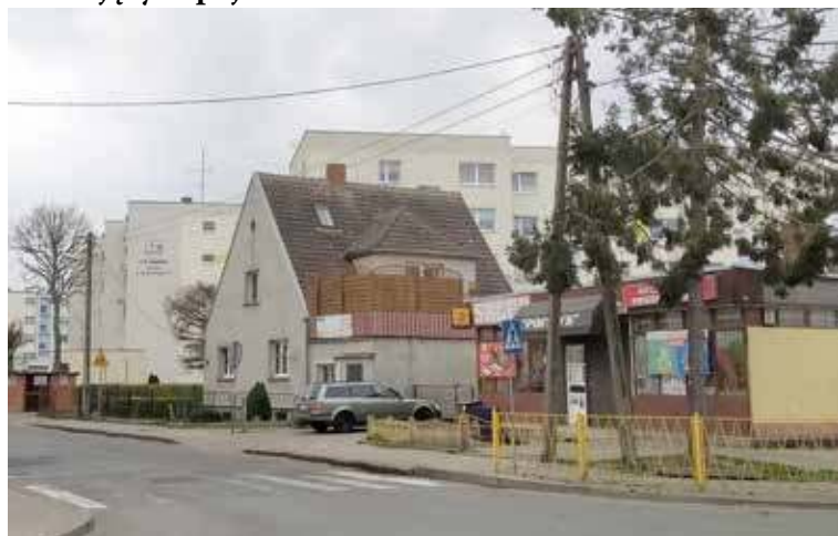
W obrębie skrzyżowania konieczne trzeba zamontować dodatkową lampę, co wpłynie na poprawę bezpieczeństwa
