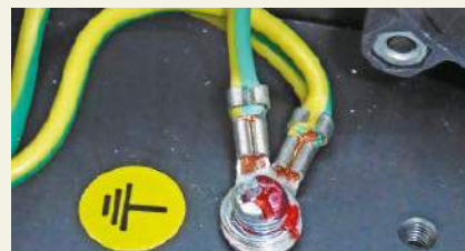
Rysunek 3.30. Pewne połączenie z uziemieniem powinno być wykonane dla wszystkich metalowych części obudowy
