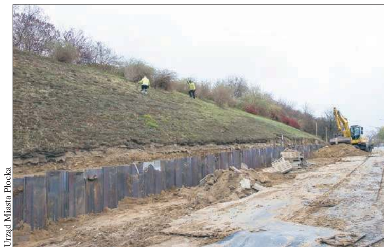
Stabilizacja skarpy wzdłuż ulicy Kazimierza Wielkiego powinna zakończyć się do 18 grudnia
