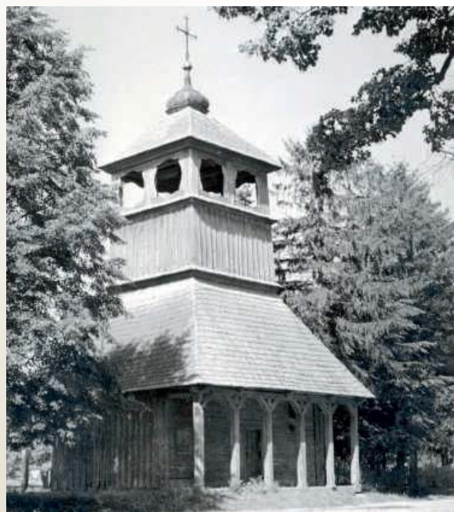
Dzwonnica przy kościele Narodzenia Najświętszej Marii Panny w Kodeńcu. Najprawdopodobniej pochodzi z końcówki XVIII wieku i jest równolatką samej świątyni. Pierwsza świątynia obrządku wschodniego została wzniesiona w Kodeńcu najpóźniej w XVI wieku. Po unii brzeskiej stała się unicką. Nową, trzynawową wzniesiono w 1795 roku. W 1875 część parafian postawiła opór przymusowemu przejściu na prawosławie (kasata unii), ale większość przyjęła nową - starą wiarę. Po I wojnie światowej świątynia została rekonyliowana na kościół rzymskokatolicki, prawosławni chodzili do cerkwi do Horostyty, albo do nieistniejącej dziś parafii w Uhninie
