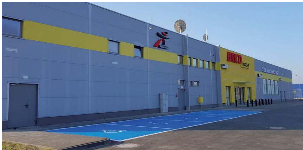
Sala sprzedaży wraz z wiatą budowlaną to 2 tys. mkw. powierzchni
