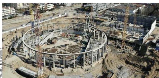
Ze starej hali zostały tylko 32 słupy żelbetowe i ring, na którym oparta jest nowa kopuła
