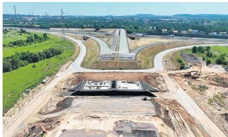
Trwa budowa drogi ekspresowej S74 Mniów - Kielce. W środę, 15 lipca wykonawca inwestycji wprowadził zmiany organizacji ruchu
