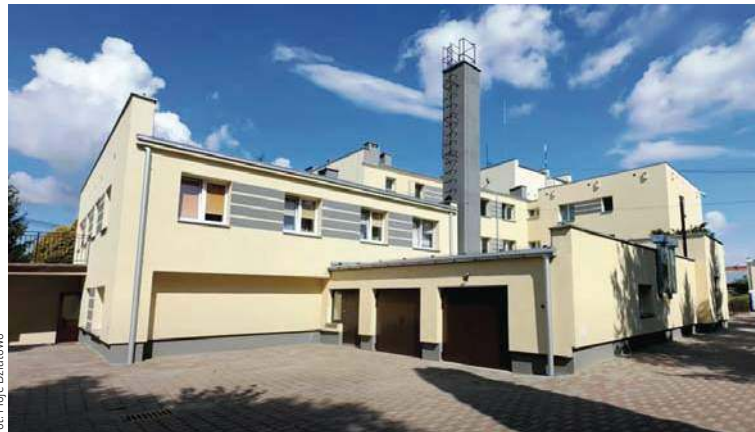
Wyremontowane budynki dps w uzdowie
