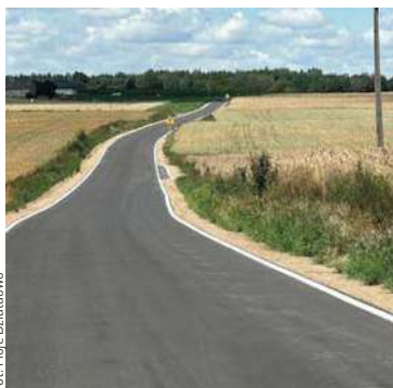
Przebudowa drogi powiatowej nr 1274N od granicy powiatu działdowskiego do skrzyżowania z drogą powiatową nr 1349N w Gronowie
