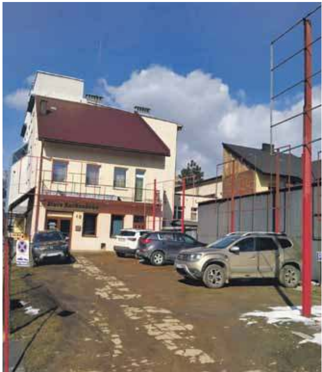
Taka instalacja pozostała po reklamach przy urzędzie.
