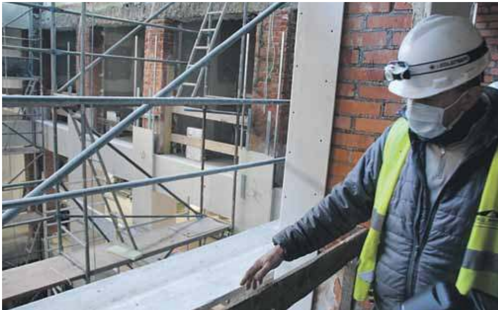
Patio ma już szklany dach, a na parterze będzie kawiarnia.
