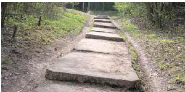
Tak schody wyglądały kilkanaście dni temu
