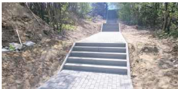
Tak wyglądają na etapie prac i układaniu nowych schodów
