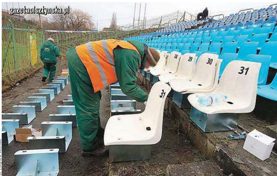
Montaż dodatkowych krzesełek na olsztyńskim stadionie
