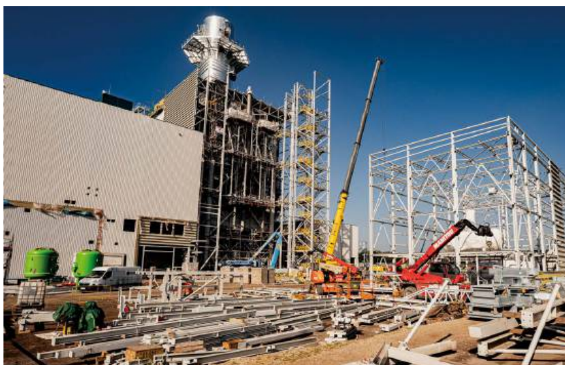
Budowany blok parowo-gazowy PGE Nowy Rybnik
