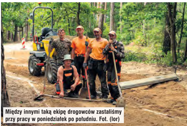
Przygotowania do montażu murów oporowych. Fot. (lor)
