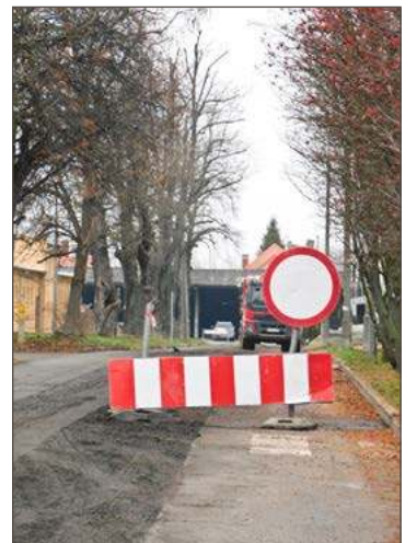
Prace na Akademickiej już trwają.
